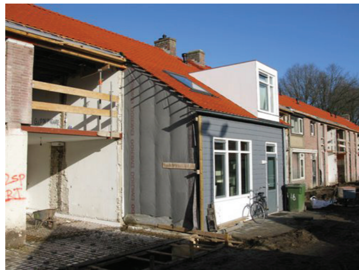
154 woningen te Tilburg De uitbouw vergroot het woonoppervlak, verbetert het energieverbruik en is een kans om de uitstraling te verbeteren.
