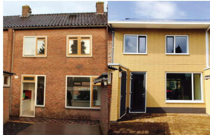
109 Energie-0 woningen in Soesterberg (met BAM W&R voor De Stroomversnelling) Een waterdicht renovatiedak met zonnepanelen is als een 'theemuts' over de bestaande woning geplaatst.
